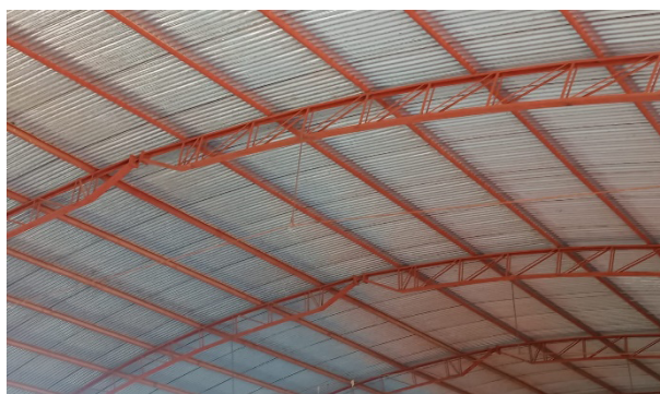
Figura 2: Cobertura do ginásio da escola
