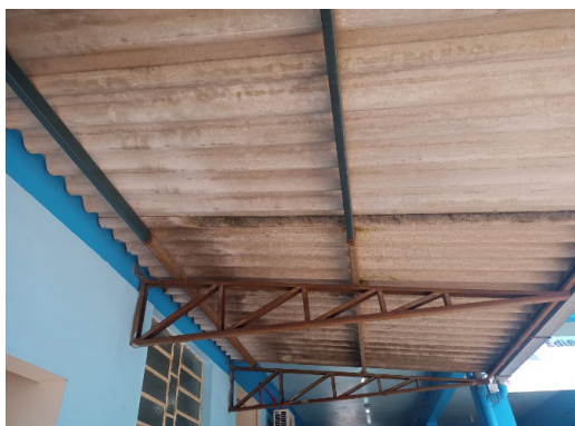
Figura 1: Cobertura de acesso aos banheiros da escola
