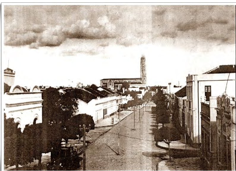
Figura 3 – Foto da Av. Padre Rolim com a Catedral em construção
