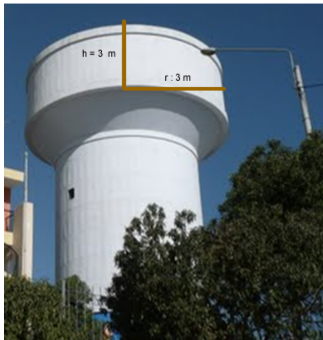
Figura 56: Tanque de agua
