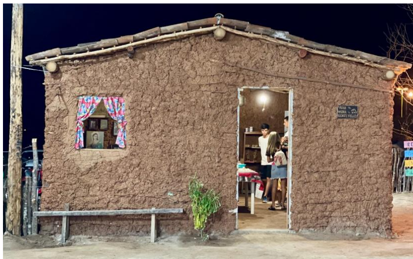
Figura 1: Casa e taipa de mão na Vila do Sertão
