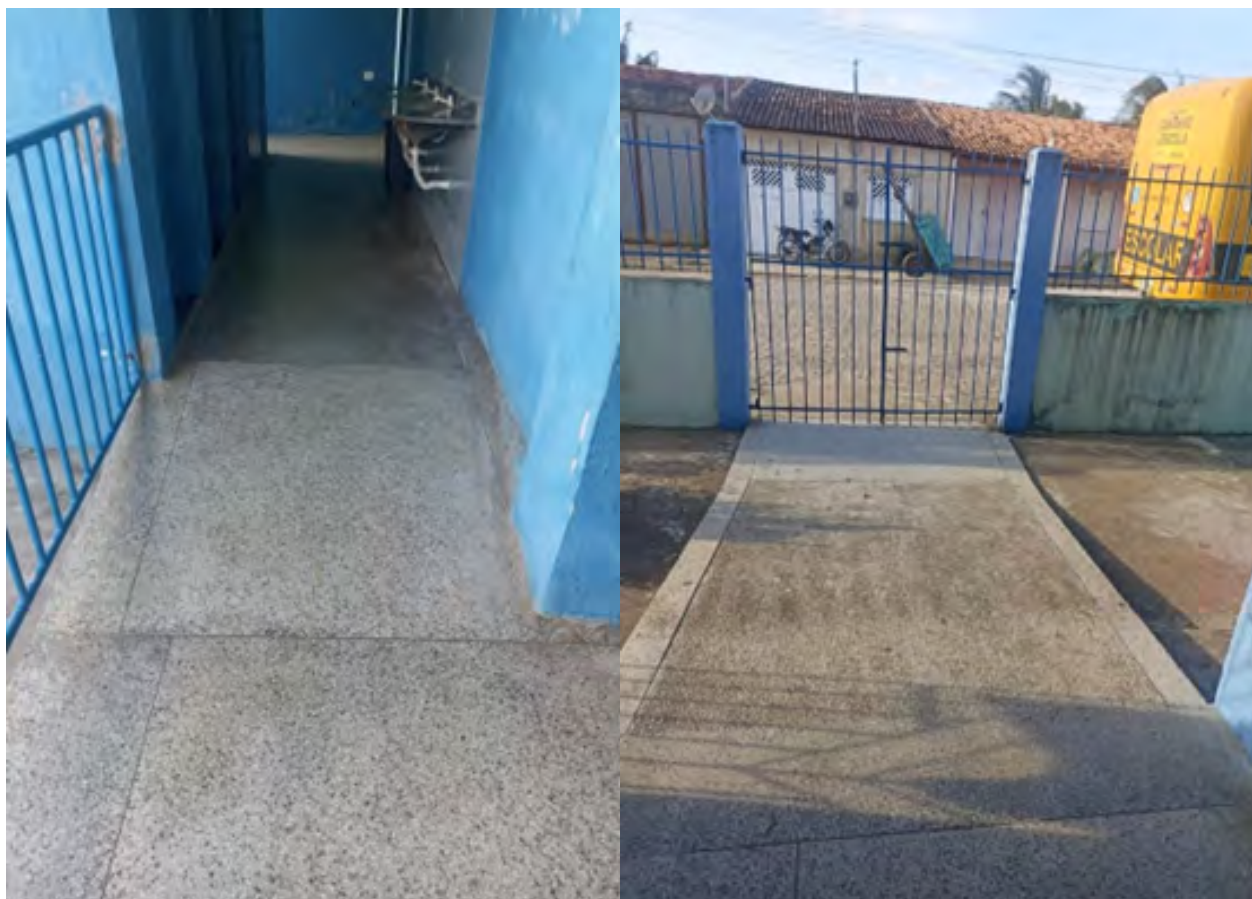
Figura 01. Estrutura física da Escola Drº João Alves Filho
