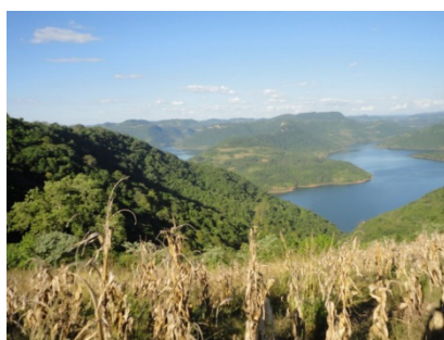
Figura 10: Vista da represa da hidrelétrica Dona Francisca entre Agudo e Nova Palma.
