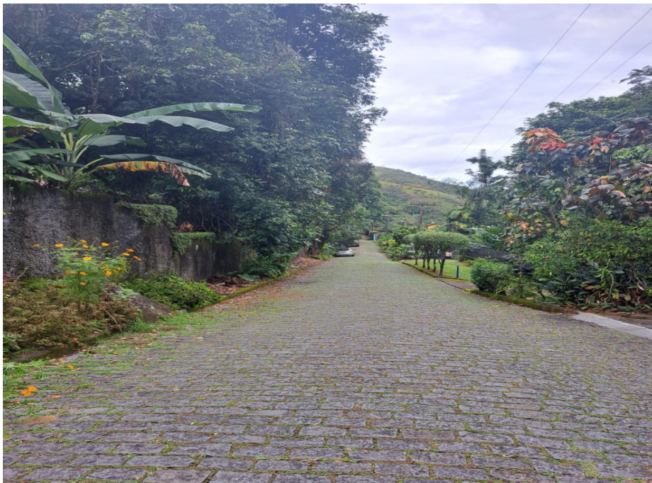
Figura 6 – Rua Vila Indiana
