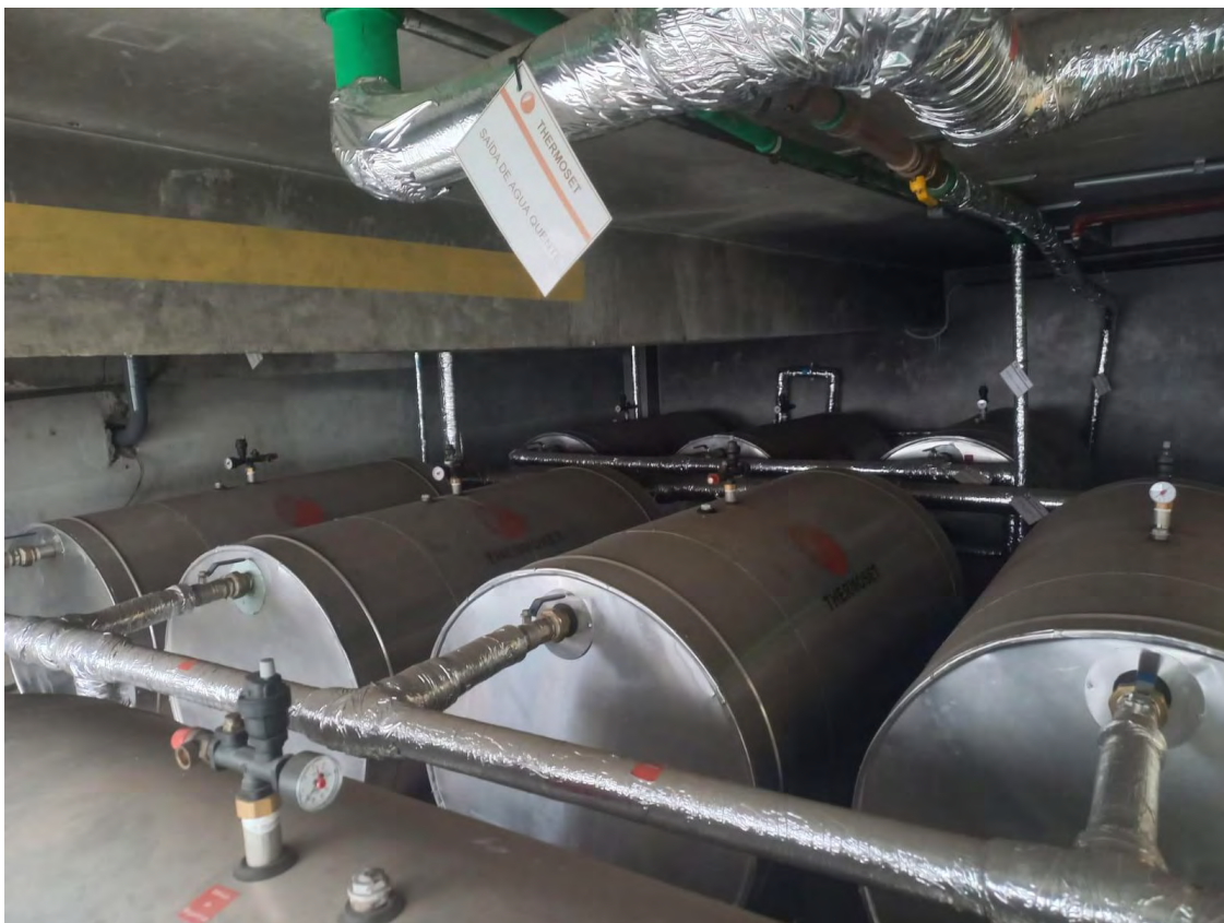
Figura 12.2 - Novos Boilers (reservatórios térmicos) instalados.
