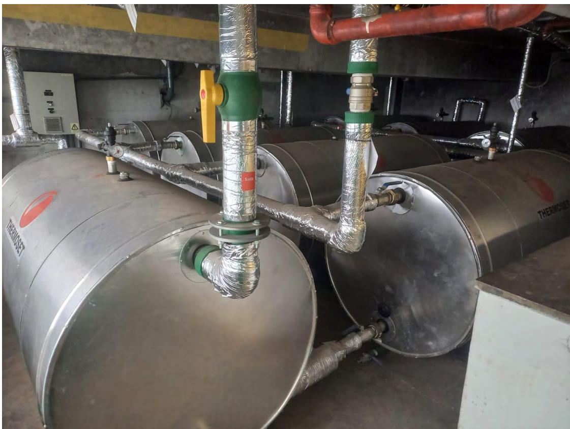
Figura 12.2 - Novos Boilers (reservatórios térmicos) instalados.
