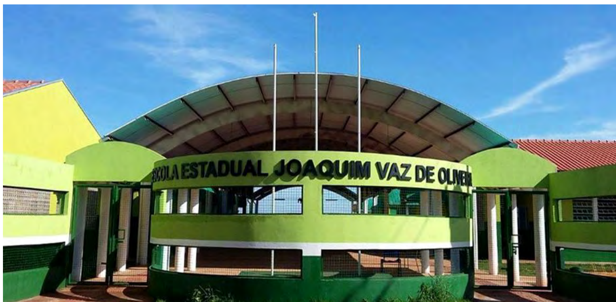
Figura 1 – Vista frontal da EE Joaquim Vaz de Oliveira
