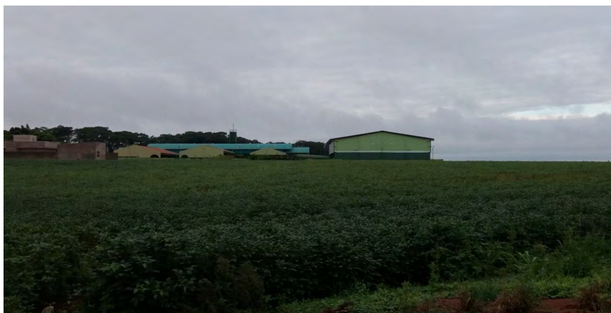
Figura 02 – Vista lateral da Escola Estadual Joaquim Vaz de Oliveira
