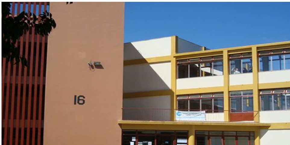
Figura 5: Centro de Educação - Prédio 16.
