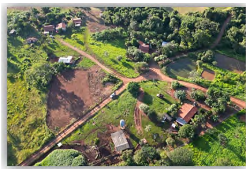
Figura 2 – Vista da comunidade do Salgado, com destaque à proximidade das casas.
