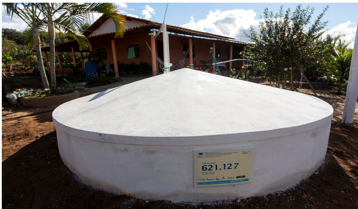
Figura 7- cisterna com captação de água da chuva.
