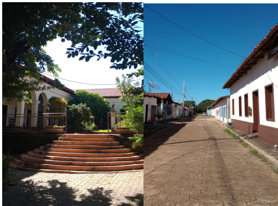
Figuras 06 e 07 – Vista interna e externa do prédio da COMSAÚDE
