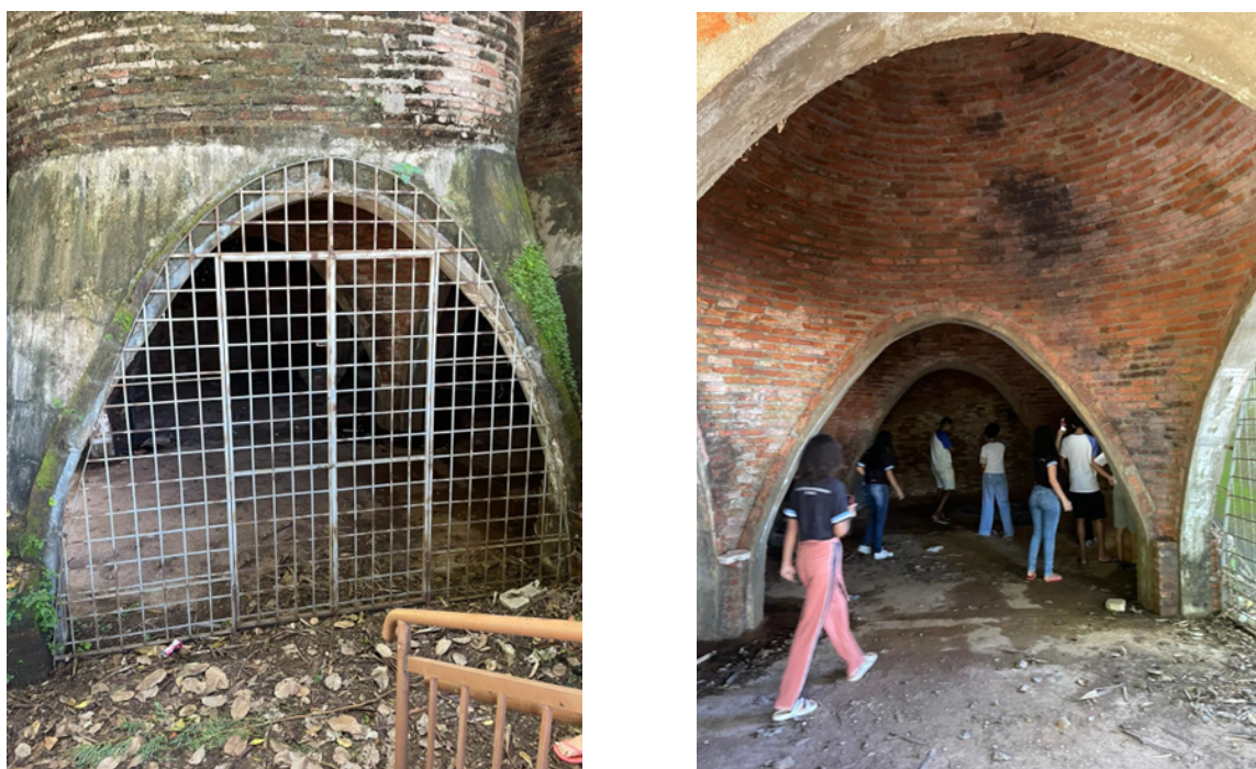
Figuras 08 e 09 – Antiga prisão abaixo do prédio da COMSAÚDE
