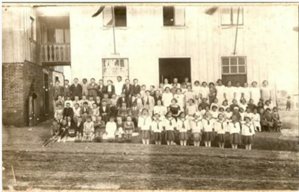
Imagem 2: Foto oficial em frente ao prédio escolar, 1928.
