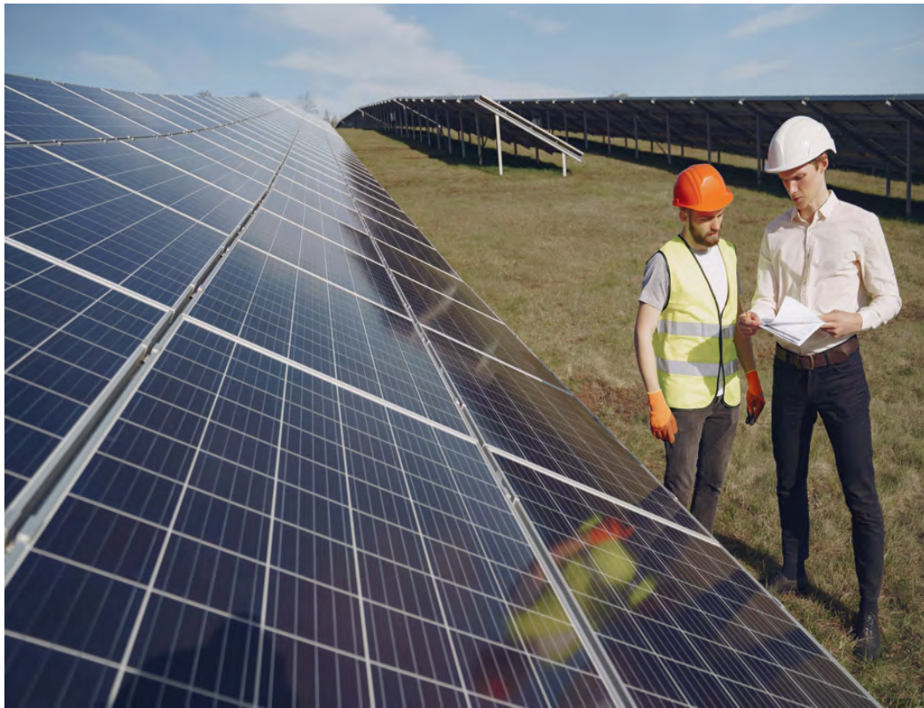
Figura 5. Mantenimiento de paneles solares
